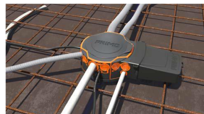
7. Закрепете монтажния корпус към арматурката за допълнителна сигурност.
